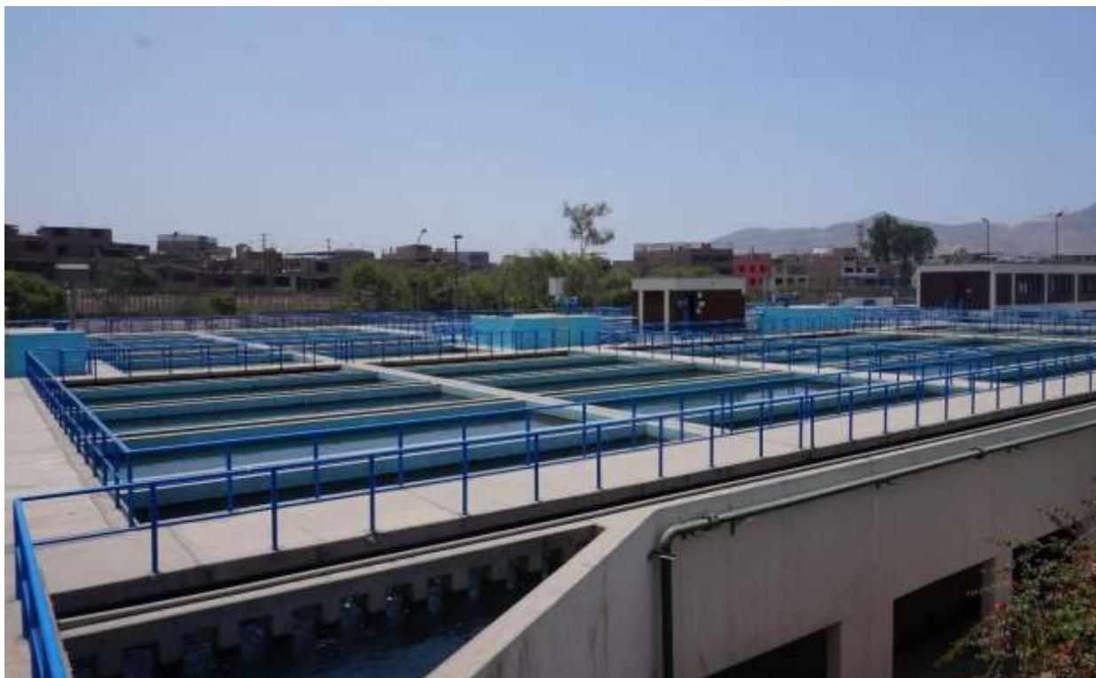
Figura 3.14: Decantadores pulsatores rectangulares de la Planta N°2 Fuente: Fotografía propia
