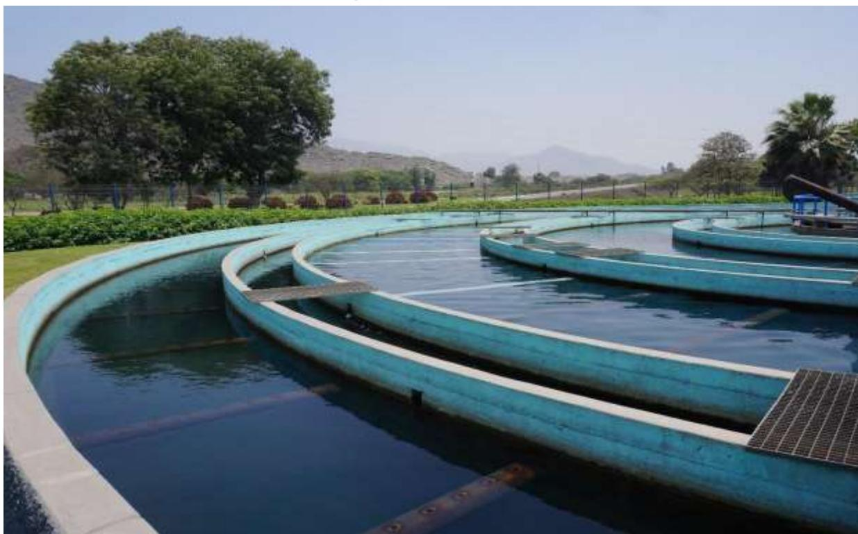
Figura 3.11: Decantador pulsator circular de la Planta N°1 Fuente: Fotografía propia
