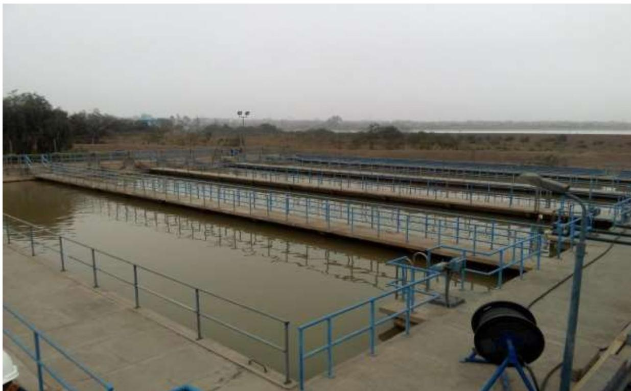
Figura 3.7: Unidades de desarenación designadas para el agua proveniente de la bocatoma N°1 Fuente:
