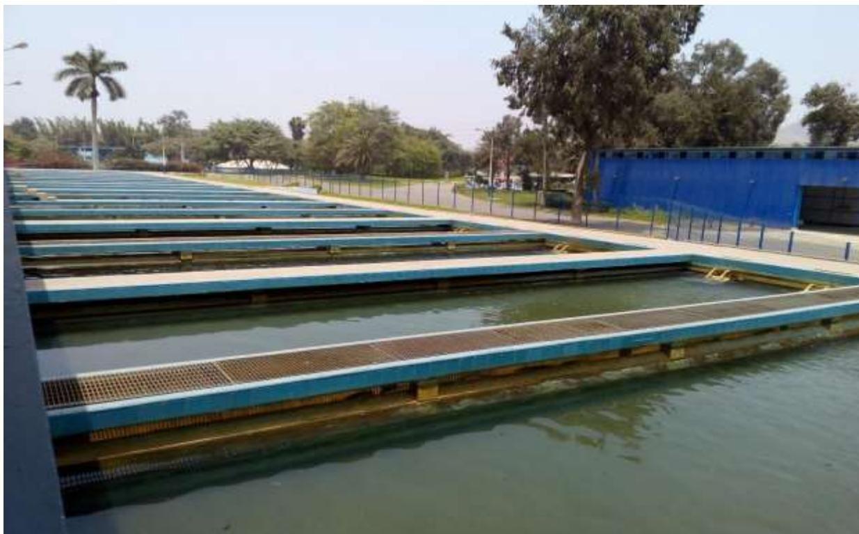
Figura 3.12: Unidades de filtros de la Planta N°1 Fuente: Fotografía propia
