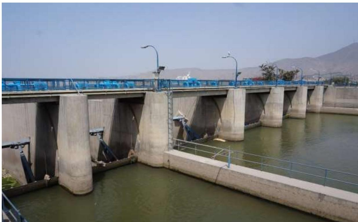
Figura 3.5: Barrajes móviles ubicados a lo ancho del río Rímac. Fuente: Fotografía propia
