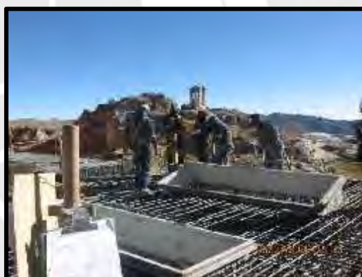
Ilustración 3: Enmallado de fierros en planta - Ares
