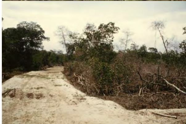
Figura 4.6c Tala de manglar para la construcción de caminos en estero Jelí. Fuente: CDC 1986, pág. s/n.
