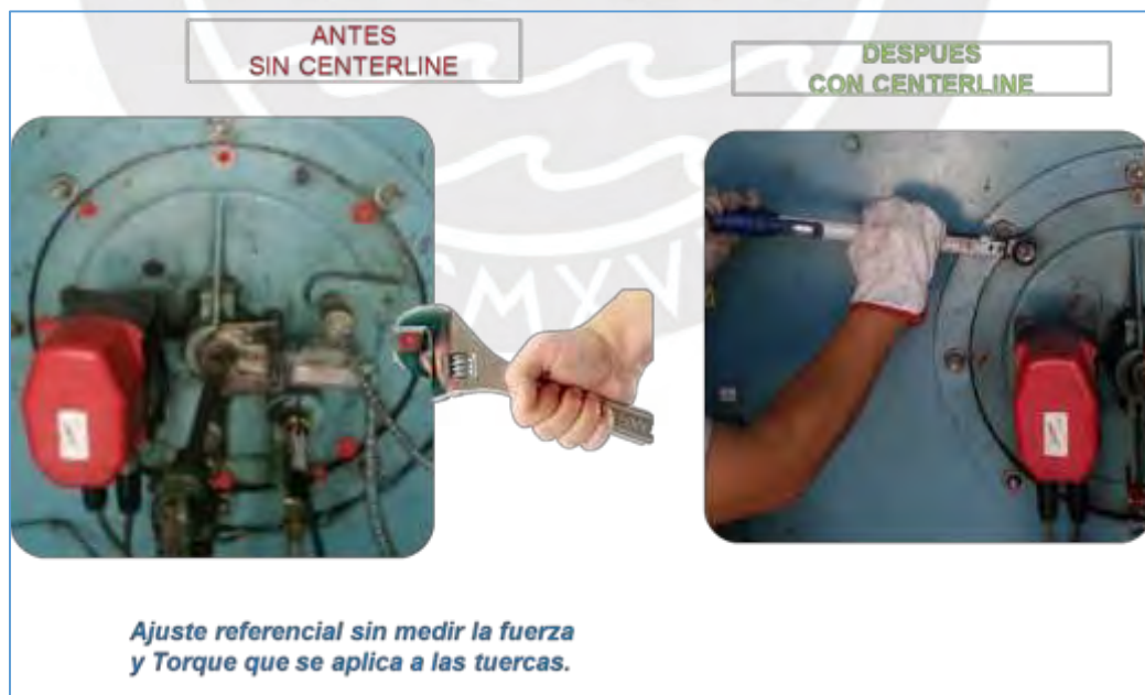
Figura 57 Control de montaje y ajuste de cuerpo de quemador. Fuente: Elaboración propia.
