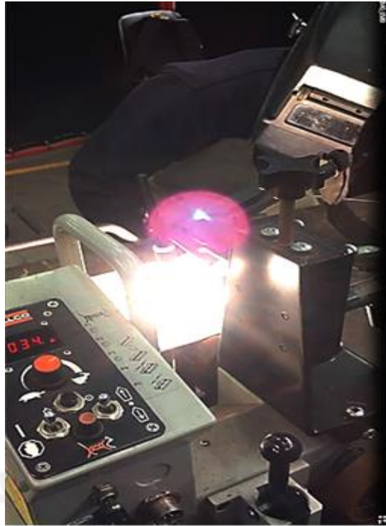
Figura 18.- Soldadura con el uso del Welding car
