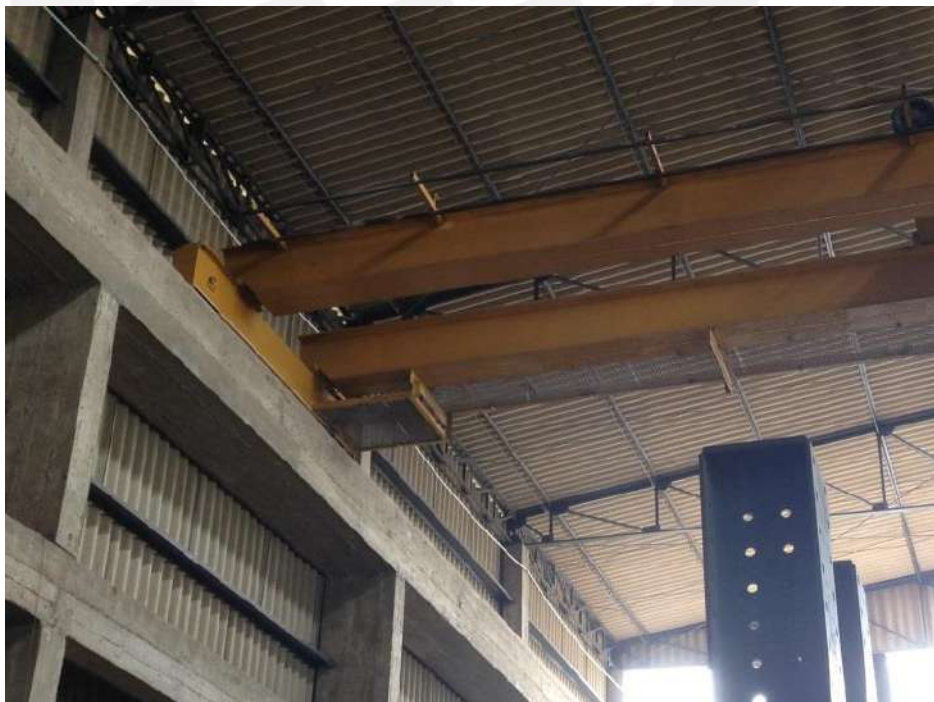
Figura 11: Nave de Laboratorio de Estructuras-PUCP.
