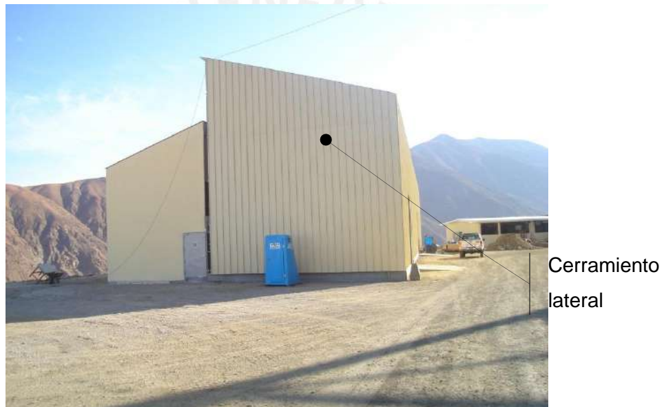
Figura 14: Vista de Cerramientos laterales-Nave de Mantenimiento-Unidad Minera Cerro Lindo.
