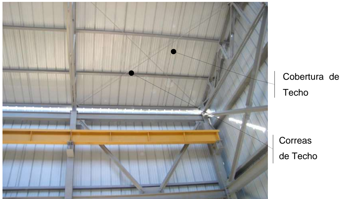
Figura 13: Vista de Cobertura de Techo-Nave de Mantenimiento-Unidad Minera Cerro Lindo.
