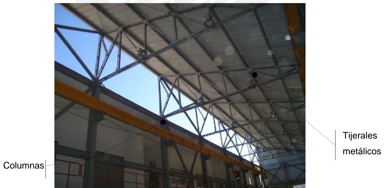
Figura 15: Vista de nave industrial de mantenimiento-Unidad Minera Cerro Lindo.
