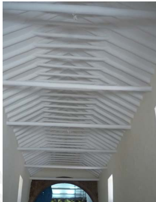
Figura 5.8. Iglesia Santa María Magdalena de Taray-Cusco, vista interior de la cobertura (sistema par y nudillo).
