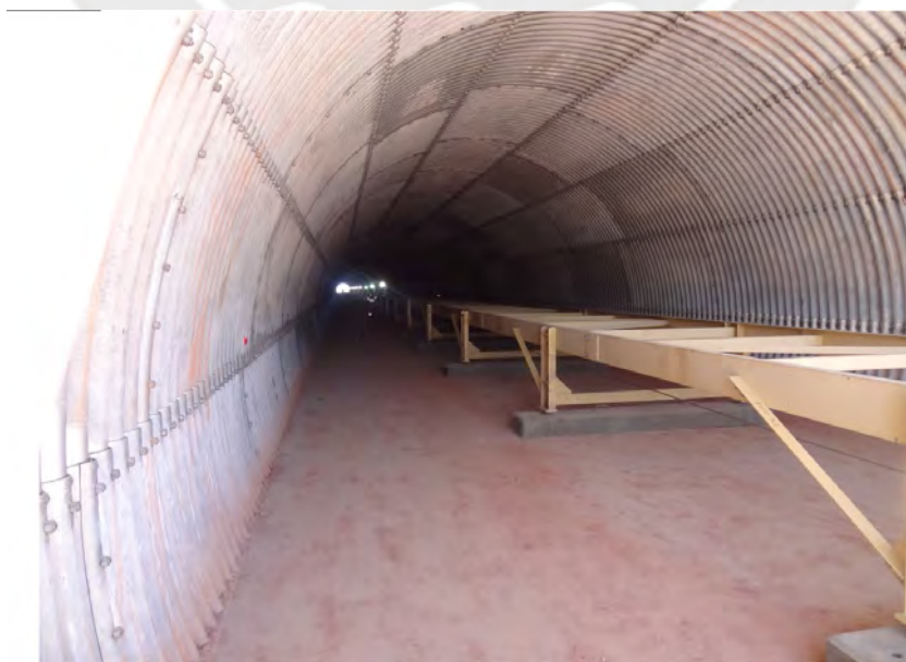
Figura 2. 9 Instalación de tramo overland al interior del túnel CV-201
