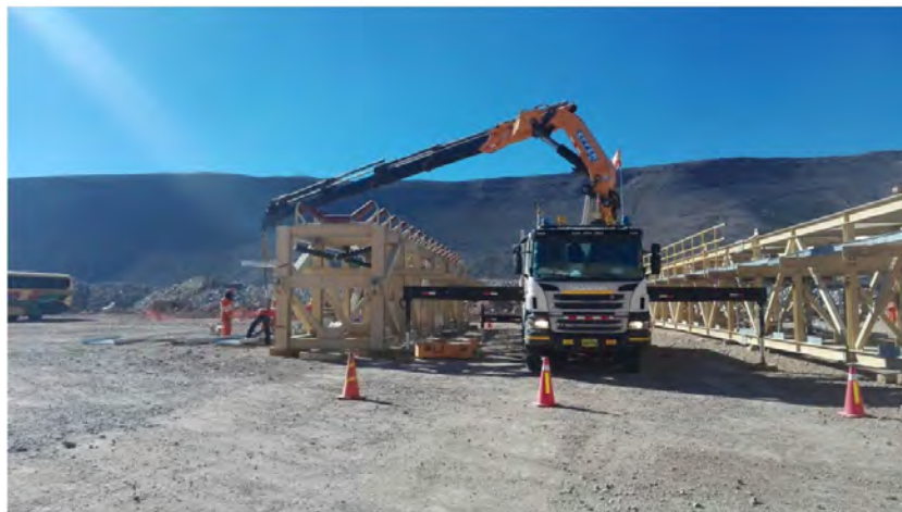
Figura 2. 6 Pre-Ensamble de estructura en zona de almacén
