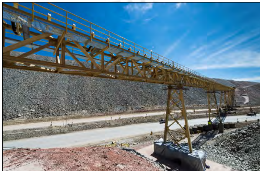
Figura 2. 2 Foto tomada durante la fase de construcción del Cruce 1, tramo en voladizo a fin de evitar la interferencia con la vía principal de camiones mineros.
