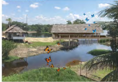
VISTA EXTERIOR PABELLÓN 2
