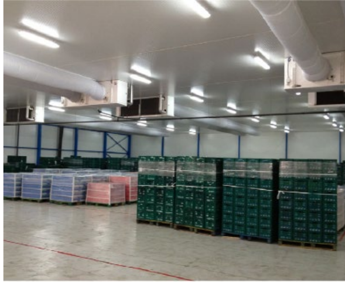
Figura 2.4 Cuarto grande de enfriamiento por convección natural
