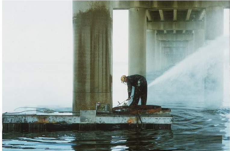
Figura 6.3: Prueba de presión de agua antes de la limpieza de superficie.
