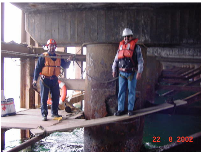
Figura 6.1: Andamio y línea de vida apoyados sobre la estructura.
