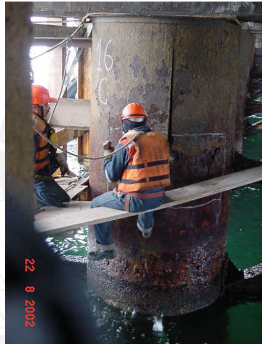
Figura 6.2: Trabajador realizando corte del fuste de acero en pilote.
