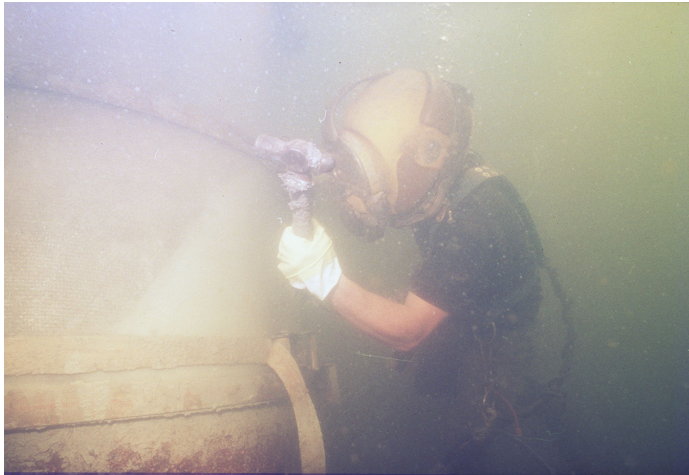
Figura 6.4: Anclaje de las camisas de fibra de vidrio.
