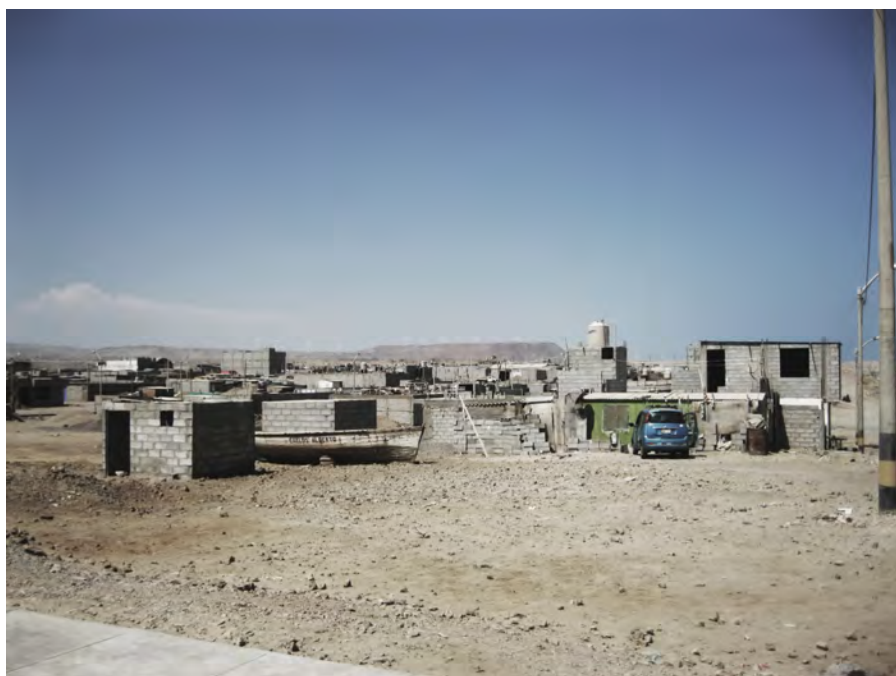
Fotografía de San Juan de Marcona 3. Vista Urbanización San Martín de Porres.
