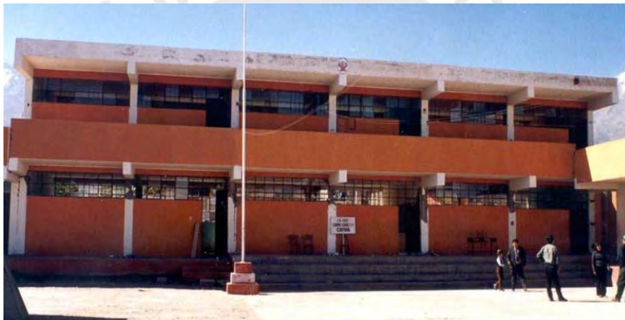
Figura 2: Edificio escolar 780 PRE (Fuente: Silva, 2012)
