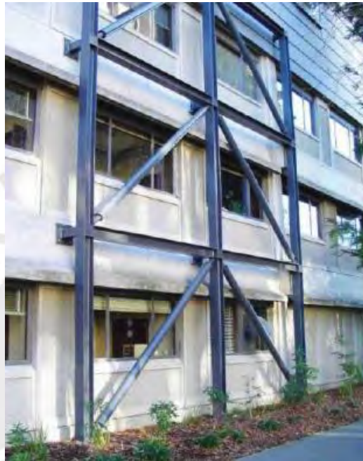
Figura 26: Pórtico arriostrado de acero (Fuente: Crisafulli, 2014)
