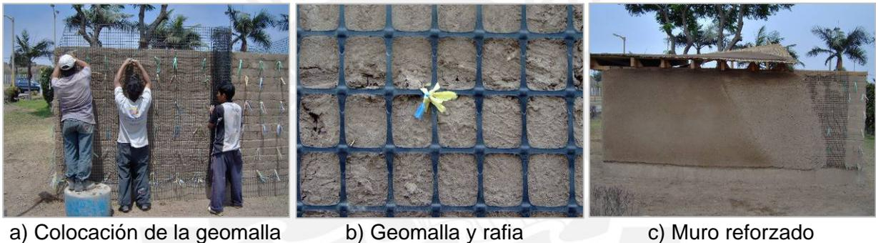
Figura 8. Refuerzo con geomalla en muros de adobe
