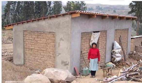
Figura 57. Vivienda reforzada construida en Arequipa
