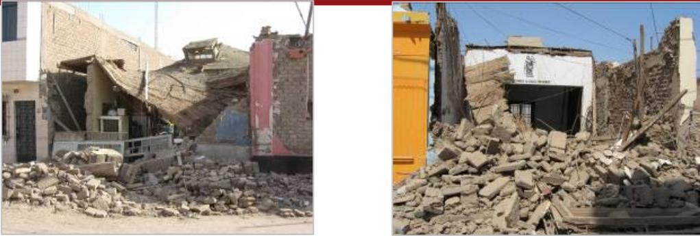
Figura 6. Construcciones de adobe destruidas por el Terremoto de Pisco
