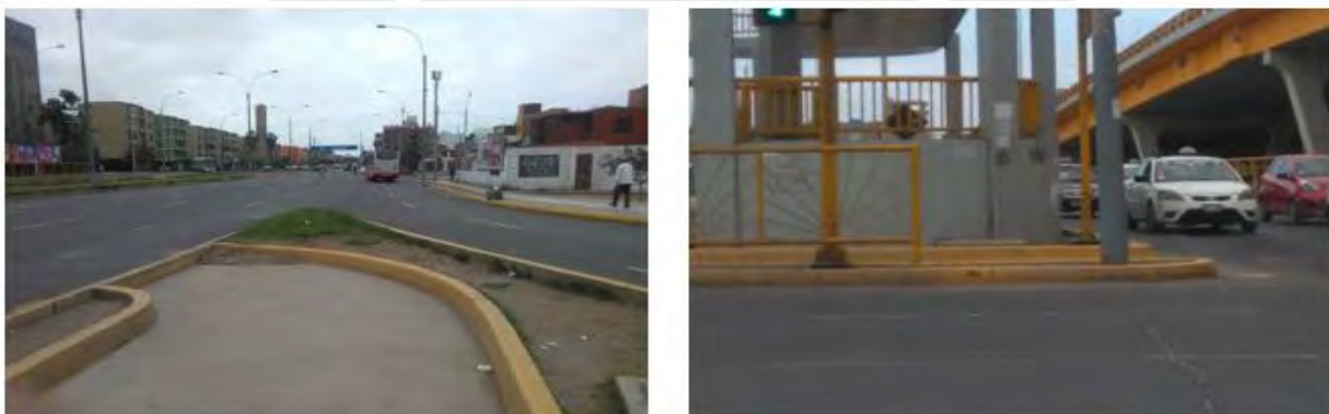
Figura 26. Cruces, debajo del puente, sin accesos para personas con movilidad reducida
