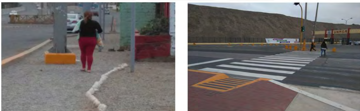
Figura 24. A la izquierda, una madre con su bebé en brazos desplazándose por el camino de grava que dejaron luego de la construcción y, a la derecha, el cruce peatonal
