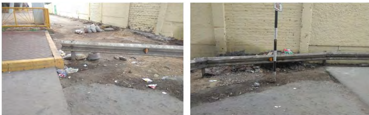
Figura 32. Basura acumulada en la zona abandonada, entre el bypass y San Marcos
