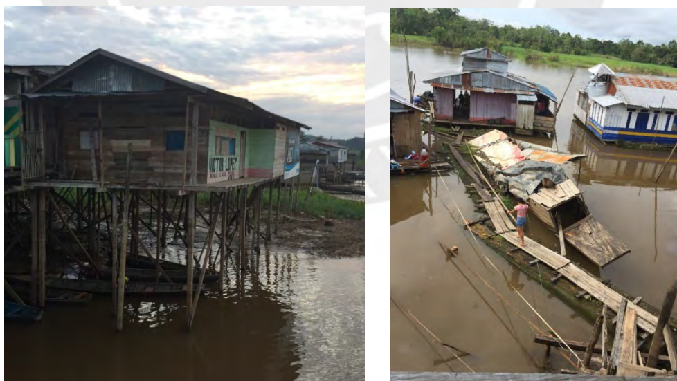
Estructuras de las viviendas en Pebas. Fotos propias.
