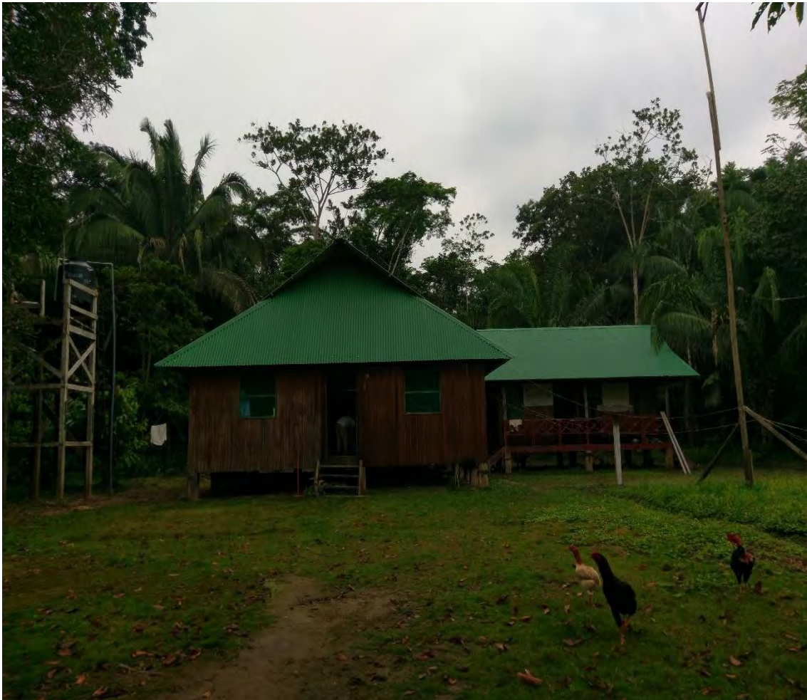
Imagen 22: Vista frontal al Puesto de Control y Vigilancia de Briolo
