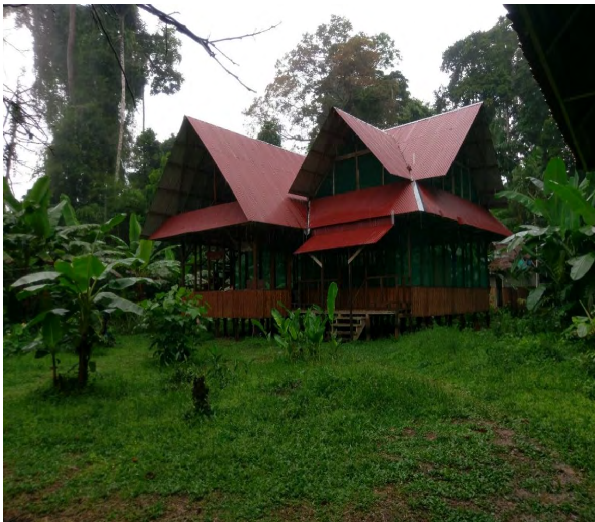
Imagen 33: Modulo amplio de dos pisos para el alojamiento y trabajo de las comitivas científicas en el PCV Malinowski
