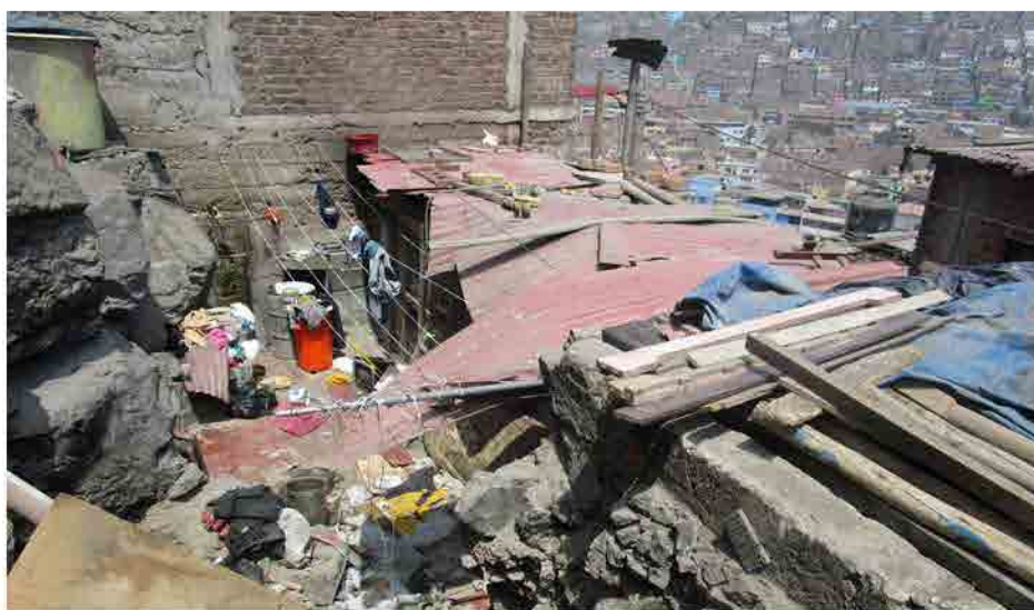
Viviendas en mal estado, San Cosme. 2018
