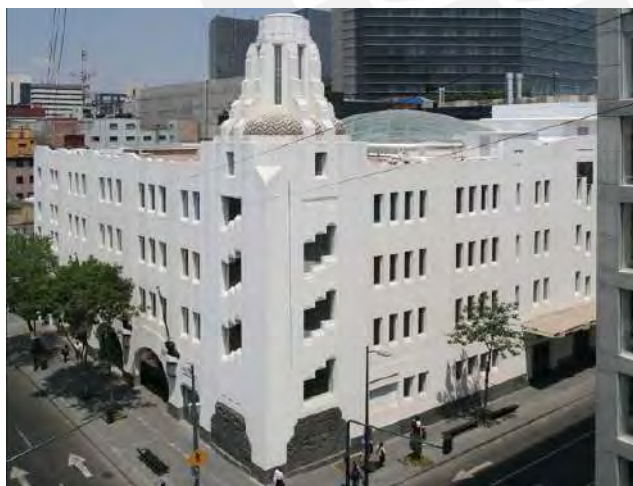
Figura 31: Vista del Edificio de Revillagigedo, antigua sede de la Inspección General de Policía y del Cuartel Central de Bomberos, hoy sede del MAP de la Ciudad de México.
