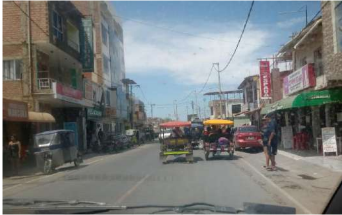
Figura 35: Derecho de vía completamente ocupado. Fuente: Propia.
