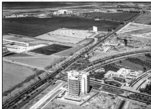
Figura 1: Intersección de la Av. Paseo de la república y la Av. Javier Prado antes del construcción de la vía expresa. Fuente: Omar Rodríguez, sf.
