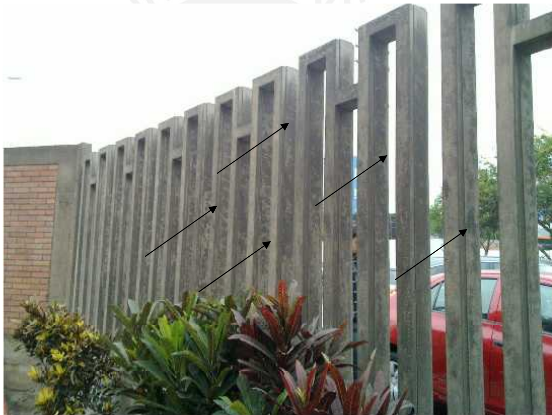
Imagen 5.2 Acumulación de CO y PM_{10} en cercos tipo UNI de concreto.
