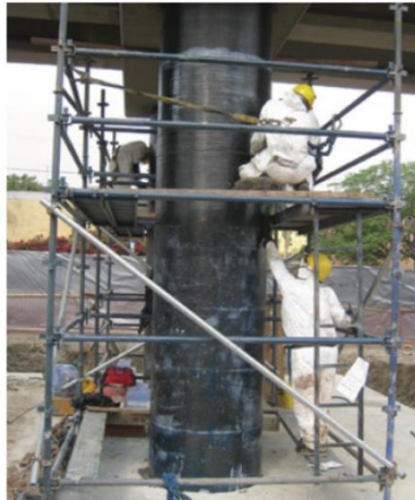
Imagen 2.9 Colocación de manta de fibra de carbono en una columna (Tantaleán, 2013)
