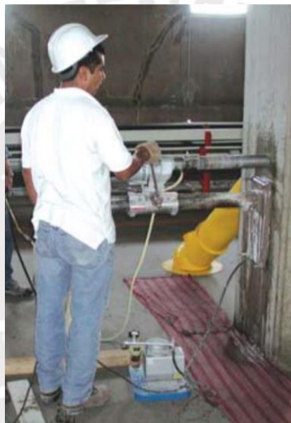
Imagen 2.4 Extracción de núcleos de concreto de una columna (Dámazo, 2006)
