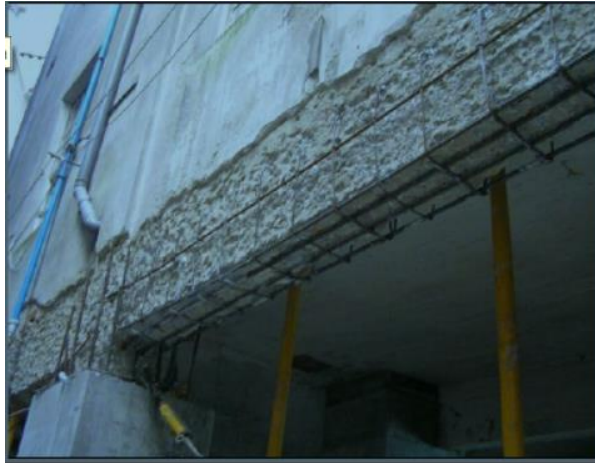
Imagen 2.11 Encamisado de vigas en obra (Vivanco, 2018)
