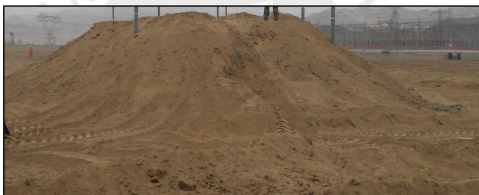
Ilustración 27 Terraplén situado en la zona de prueba
