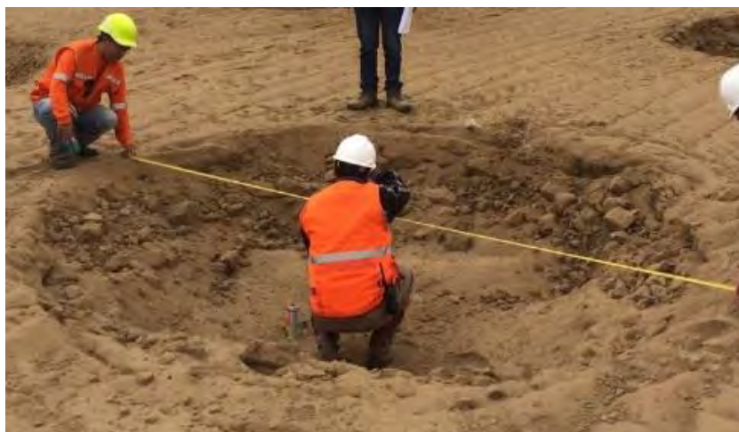
Ilustración 11 Asentamiento después de realizada la compactación dinámica
