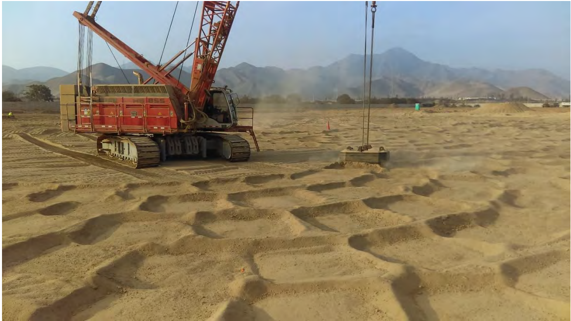
Ilustración 25 Proceso de planchado de superficie
