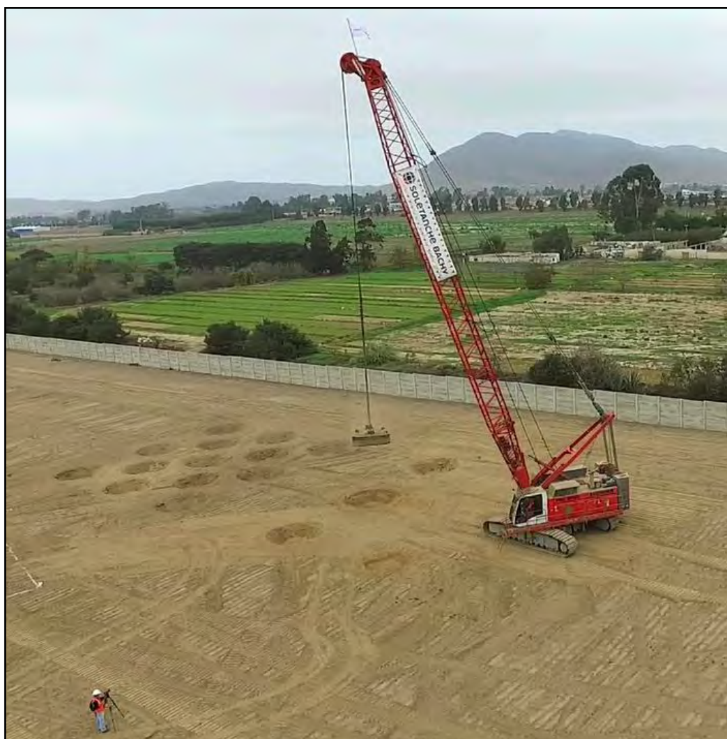
Ilustración 24 Primera compactación dinámica en Perú
