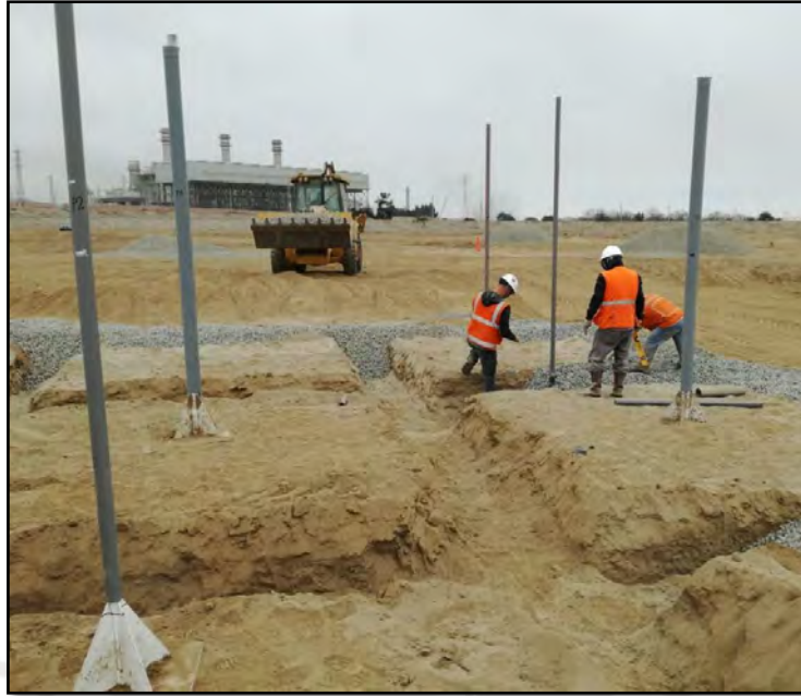
Ilustración 28 Platos de asentamiento colocados en zona de prueba
