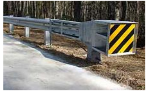
Fig. 3.33: Terminal SKT-350 Fuente: GSI
