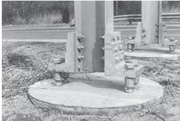
Fig. 2.1: Base traspasable multidireccional Fuente: (Brockenbrough, 2009)
