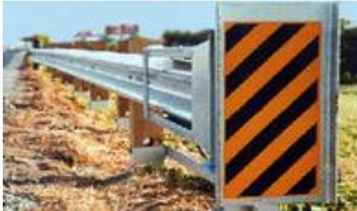
Fig. 3.32: Terminal Extruder (ET-Plus) Fuente: HelloTrade
