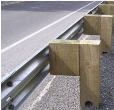
Fig. 3.5: Viga W con poste fuerte Fuente: FHWA
