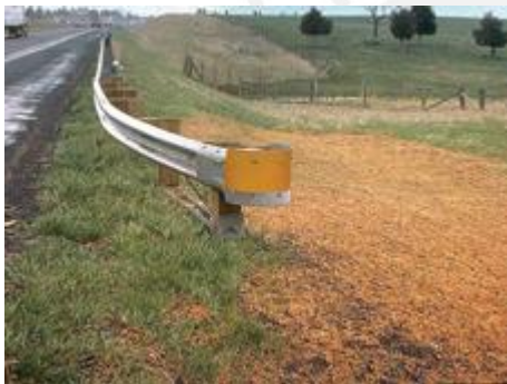
Fig. 3.28: Terminal de carga excéntrica modificado
