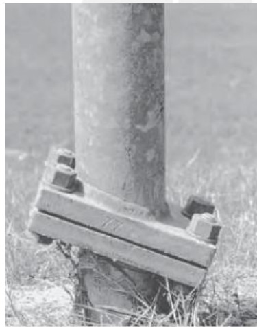
Fig. 2.2: Base traspasable unidireccional Fuente: Brockenbrough, 2009
