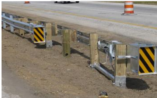
Fig. 3.36: Terminal FLEAT-MT Fuente: Road System Inc.
