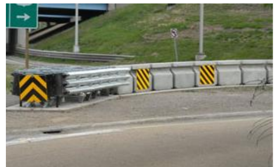
Fig. 3.20: Barrera móvil Quickchange Fuente: PCi Roads
