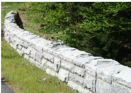
Fig. 3.19: Barrera de mampostería de piedra Fuente: FHWA
