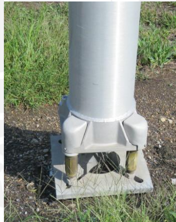
Fig. 2.6: Base frágil acoplada Fuente: Nikolic, 2007
