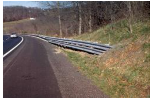
Fig. 3.27: Terminal enterrado en pendiente de subida
