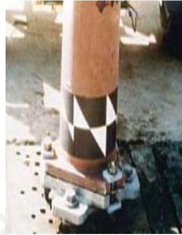
Fig. 2.5: Base deslizable Fuente: Roadside Design Guide, 2011
