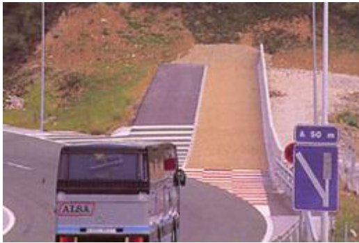
Fig. 3.61: Lecho de frenado en curva Fuente: Aucalsa
