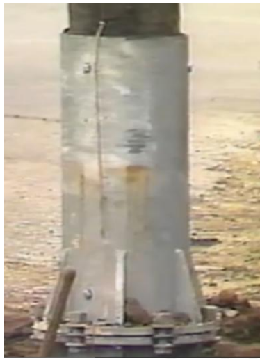
Fig. 2.7: Base articulable deslizable
