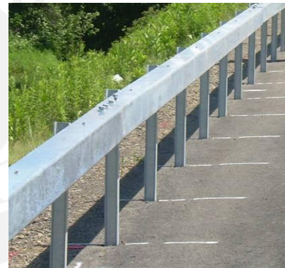
Fig. 3.6: Viga tipo caja Fuente: Elderlee
