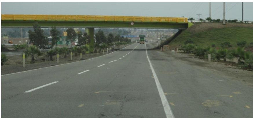
Fig. 4.1: Puente vehicular Fuente: Propia
