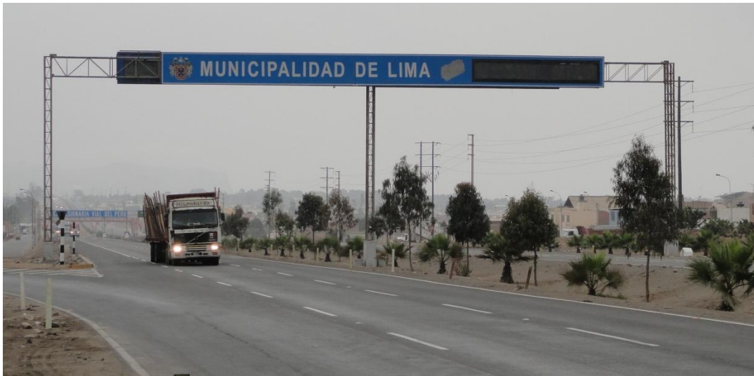
Fig. 4.2: Pórtico de señalización en la carretera Fuente: Propia
