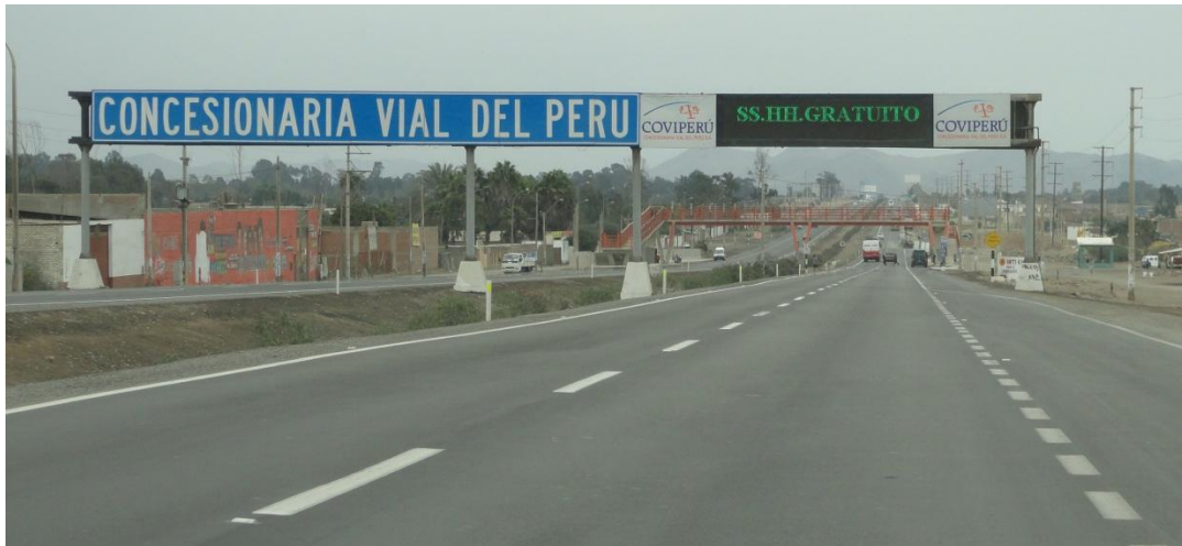
Fig. 4.3: Pórtico de señalización en la carretera Fuente: Propia
