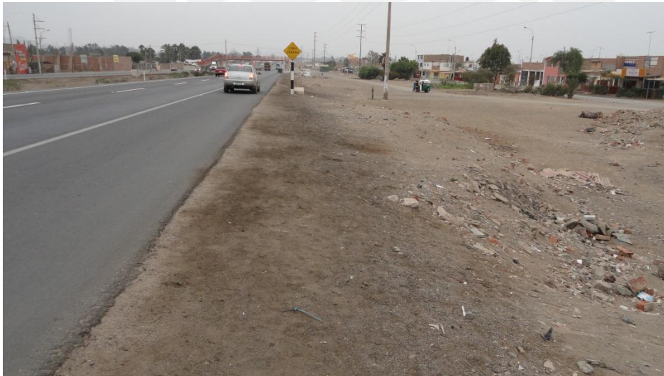
Fig. 4.4: Borde de la vía de sección crítica
