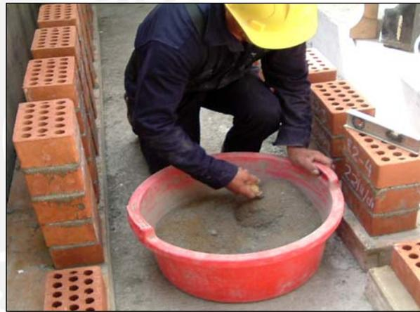
Según la NTE E.070 Albañilería (SENCICO 2004); nuestro mortero es del tipo P2, que es empleado para la construcción de muros portantes.
