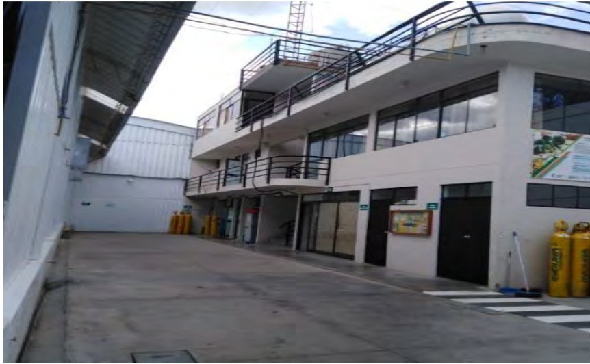
Figura Q9: Oficinas de la planta de AGROPIA Ltda.
