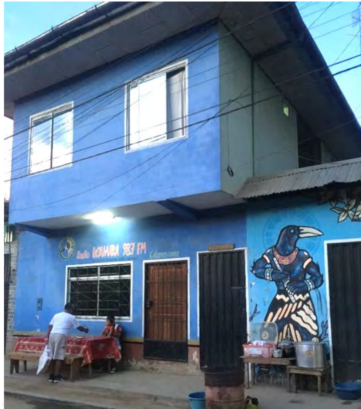
Fotografía 4: Fuente propia. Fachada del local de Radio Ucámara. 13/11/2019
