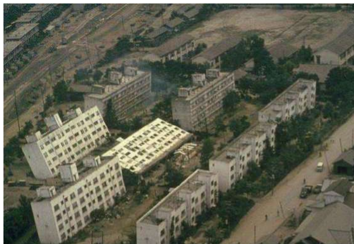
Figura 7. Efectos del fenómeno de licuefacción después del terremoto de Nigata.
