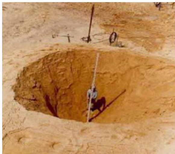
Figura 20. Cráter producido después de la aplicación de compactación dinámica.
