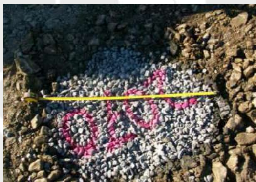
Figura 16. Superficie al exterior de columna de grava.
