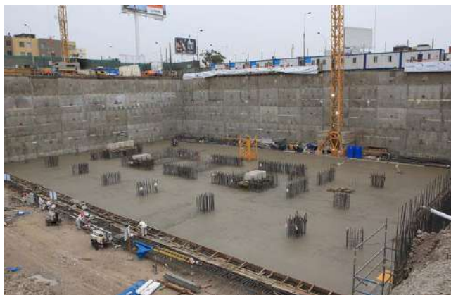
Figura 10. Vista constructiva de platea de cimentación.
