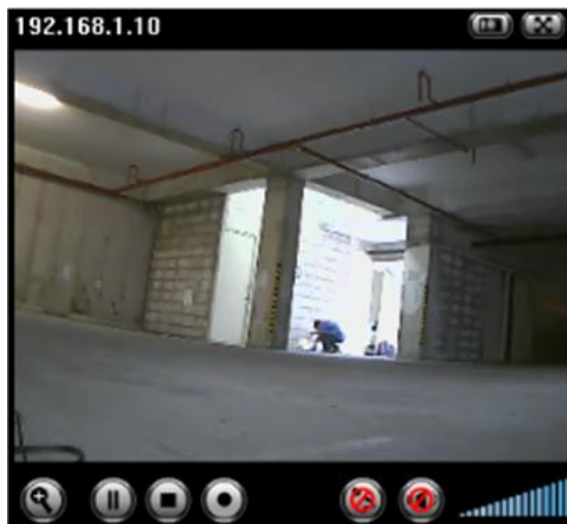
FIGURA 4- 11: Vista a 15 metros del tablero general
