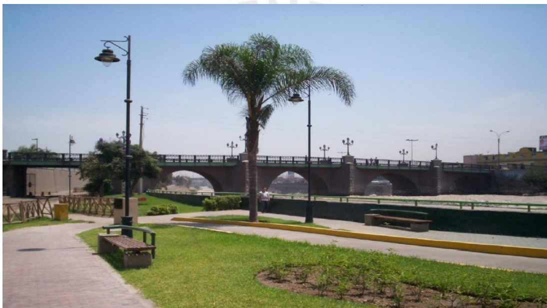
Figura 4.2. Vista actual Puente Trujillo desde el Parque de la Muralla (Bardales, 2013, p. 105).
