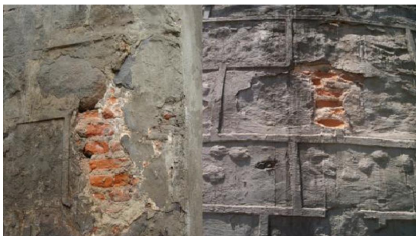
Figura 4.6. Mampostería de piedra y ladrillo usada en los pilares del Puente Trujillo, revestida con un tarrajeo de concreto, simulando una mampostería de sillería regular (Bardales, 2013, p. 110).
