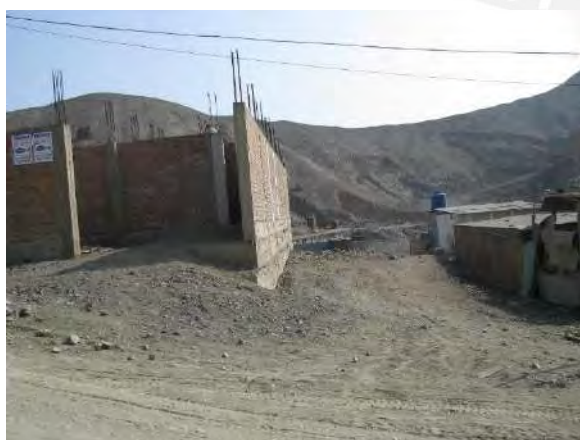
Foto N°17: Desnivel entre lote y lote (podría generar problemas para desfogar el agua en una red condominial de alcantarillado)
