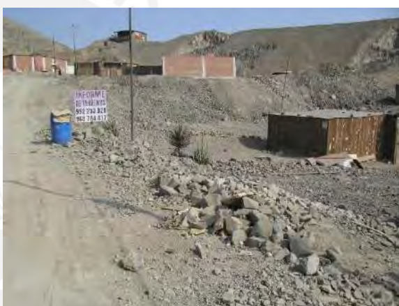
Foto N°16: Desnivel entre avenida y lote (podría generar problemas para desfogar el agua desde el lote a la red de alcantarillado)
