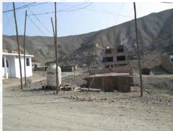
Foto N°10: Desnivel entre calle y lote (podría generar problemas para desfogar el agua desde el lote a la red de alcantarillado)
