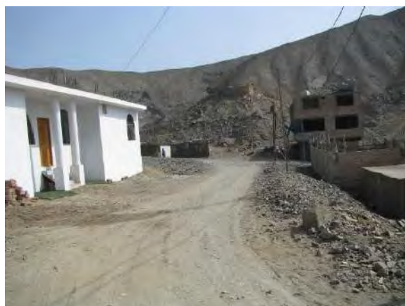
Foto N°13: Calle Pukara (Se aprecia desniveles notorios entre calle y lote que podría generar problemas para desfogar el agua desde el lote a la red de alcantarillado)
