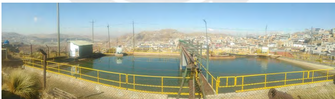
Fotografía 8: Planta de Tratamiento de Agua Potable - Cerro SAC
