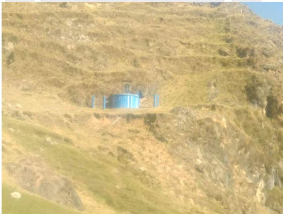
Fotografía 36: Tanque de agua - Distrito de Yanahuanca
