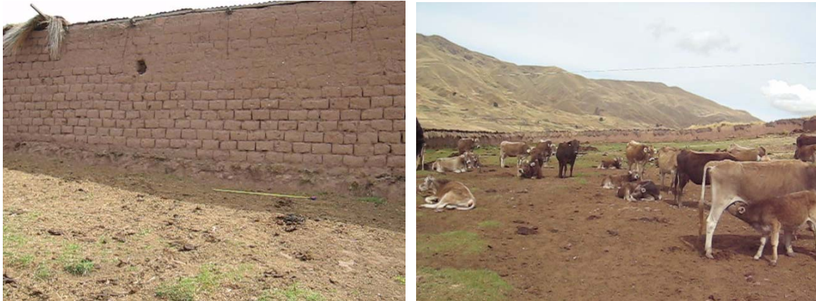
Fig.5 Estado actual de la zona de ordeño
