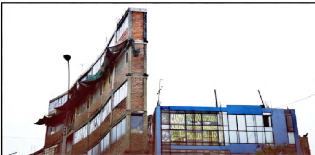
Figura 2-2 Vivienda construida de manera informal.
