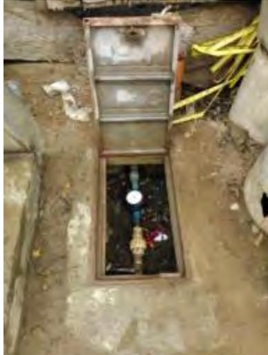
Imagen 1. Medidor de consumo de agua en sistema de pilones
