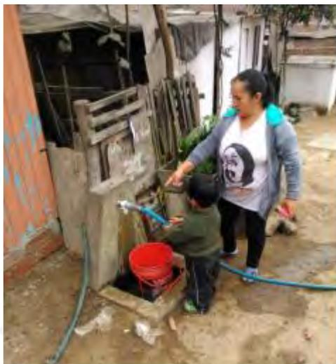
Imagen 2. Sistema de abastecimiento en base a tanque de almacenamiento, pilones y mangueras
