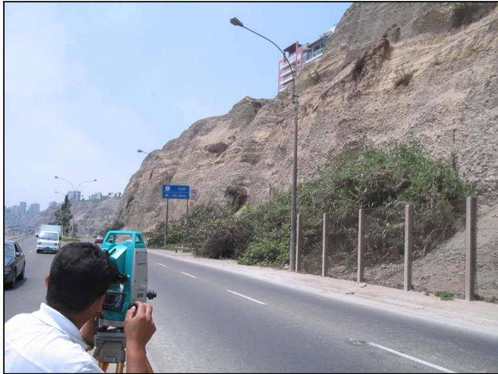
LEVANTAMIENTO TOPOGRÁFICO CON UNA ESTACIÓN TOTALSOKKIA 630R
