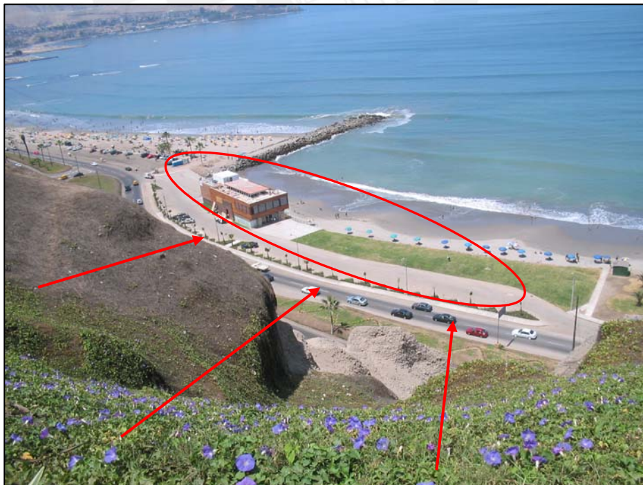
SE APRECIA EL PELIGRO QUE OCACIONARÍAN DERRUMBES LOCALIZADOS O FALLAS TOTALES SOBRE LAS NUEVAS INSTALACIONES QUE SE ESTAN CONSTRUYENDO ASI COMO SOBRE LOS VEHÍCULOS.
