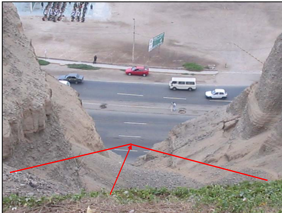
QUEBRADAS POR DONDE SE RECOMIENDA LANZAR EL MATERIAL DEL CORTE PARA SER TRANSPORTADO HASTA EL RESPECTIVO RELLENO
