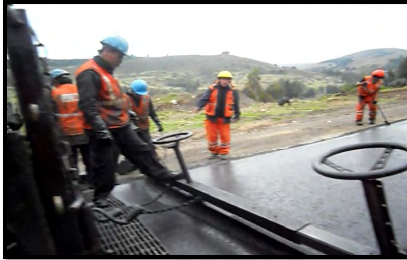
Figura 30. Máquina Micropavimentadora colocando el micropavimento Fuente. Proyecto de conservación vial (2017)
