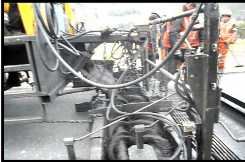
Figura 29. Máquina Micropavimentadora Fuente. Proyecto de conservación vial (2017)
