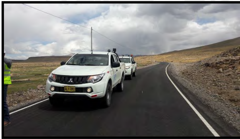
Figura 31. Pavimento básico culminado con el pintado Fuente. Proyecto de conservación vial (2017)
