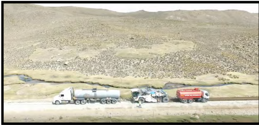
Figura 27. Máquina mezcladora del proyecto con la cisterna de agua y la cisterna de emulsión asfáltica Fuente. Proyecto de conservación vial (2017)
