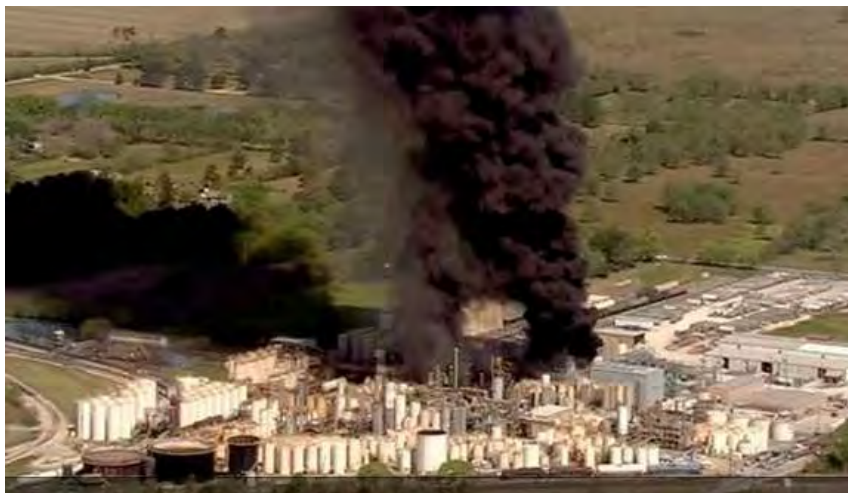
Figura 2.13: Incendio en planta industrial. Fuente: [11]
