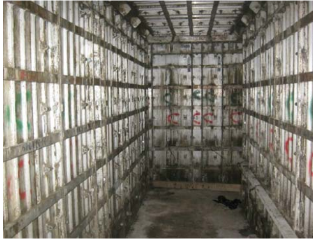
Fig. 23. Encofrado para vaciado monolítico
