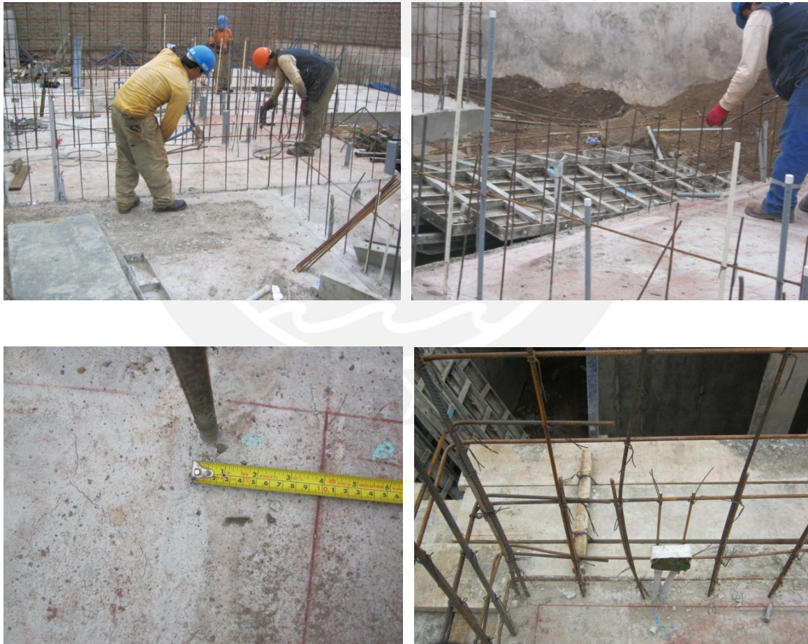
Fig. 24. Instalación de acero en muros
