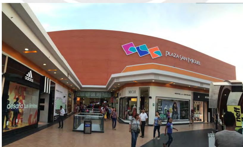
Ilustración 48. Centro Comercial Plaza San Miguel. Fuente: https://www.peru-retail.com/peru-plaza-san-miguel-mix-comercial/
