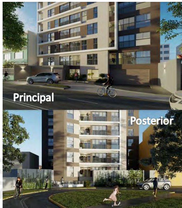
Ilustración 71. Doble ingreso peatonal, avenida principal y acceso a parque posterior. Fuente: Inmobiliaria Quatro.
