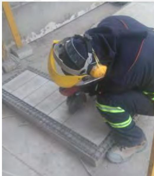
*Figura 23- Corte de los paneles en piezas rectangulares*
