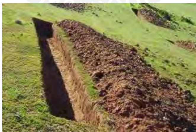
Figura 43. Zanjas de infiltración
