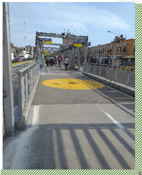
Figura 4. 12 Falta de bandas longitudinales dentro de la estación España.
