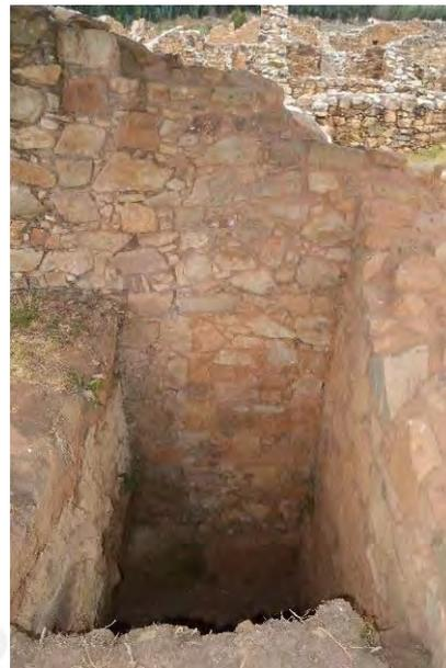
*Figura 72.* Cimientos profundos para la construcción de cimientos en Wiracochapampa.
