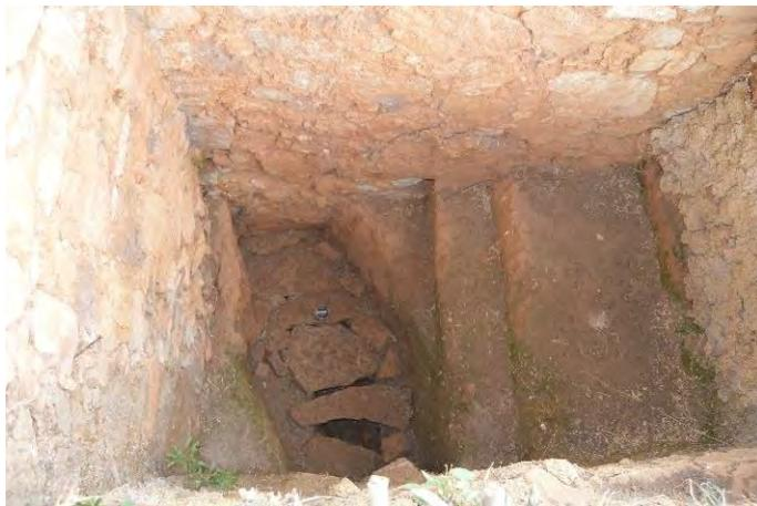
*Figura 71.* Canales de drenaje elaborados a una profundidad de 3mts – Wiracochapampa.
