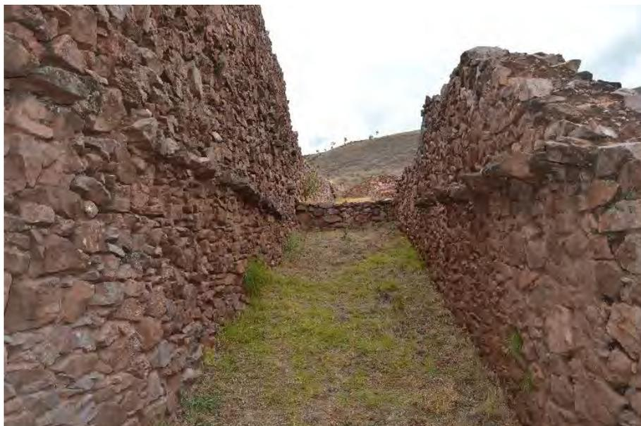
Figura 93. Galería en Pikillaqta de aproximadamente 30 m de largo por 2 m de ancho; en la parte media de ambos muros se nota la presencia de ménsulas que indican la antigua existencia de un segundo nivel.
