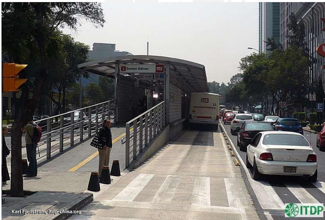
Figura 2-13: Estación "Doctor Gálvez" del Metrobús, en la que se puede observar el carril exclusivo separado por medio de bordillos Fuente: ITDP, 2018
