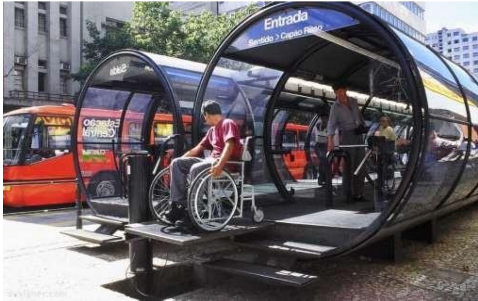
Figura 2-7: Estación típica en Curitiba Fuente: RIT, 2010
