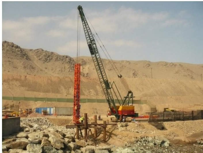
Figura 1. Hincado de pilotes
