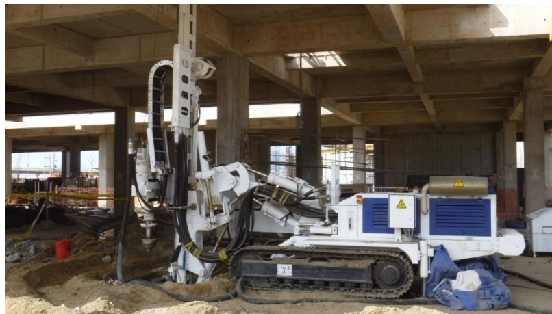
Figura 5. Micropilotes en área restringida para Megacentro Chimbote
