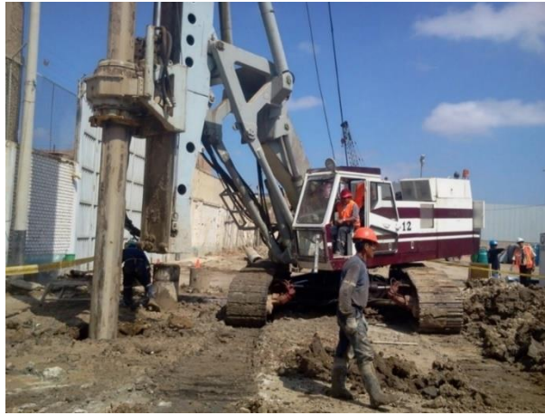
Figura 3 . Perforación sin entubación
