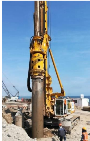
Figura 4 .Perforadora Bauer BG 28v introduciendo la camisa metálica
