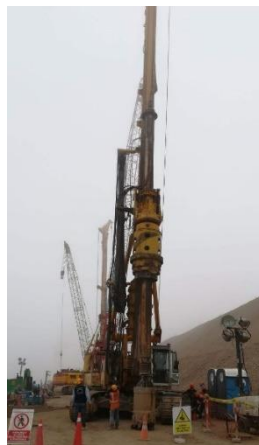
Figura 2. Perforadora con core barrel
