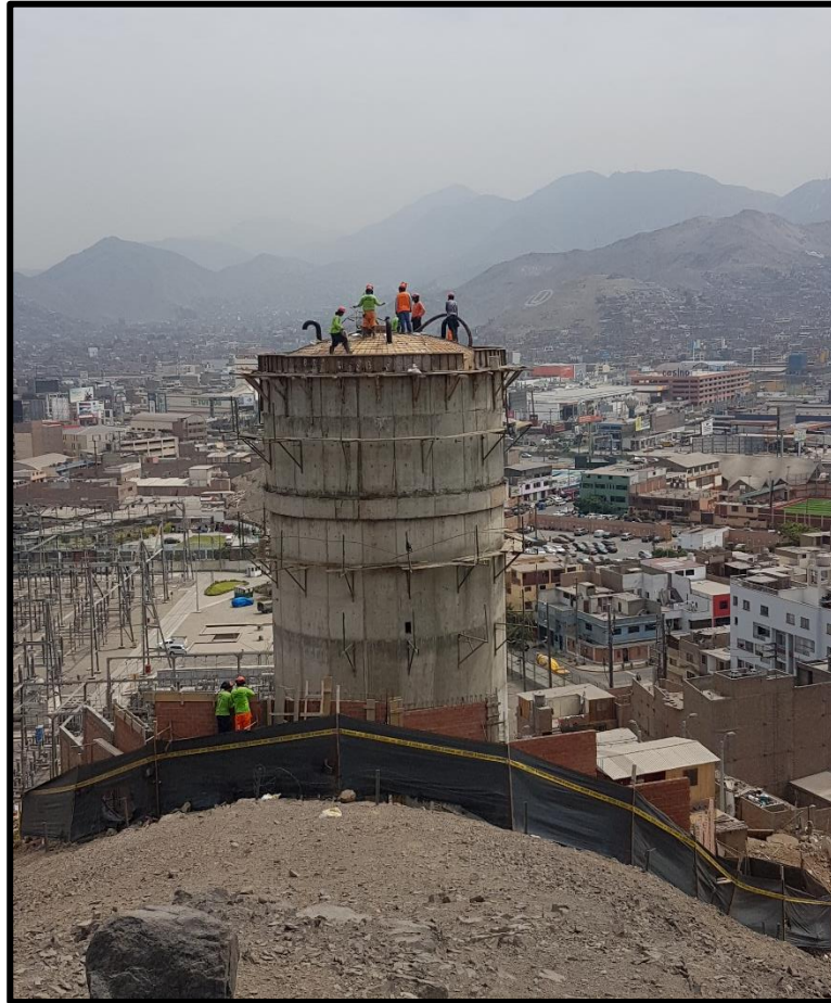
Figura N°9: Vaciado de concreto para el fondo esférico
