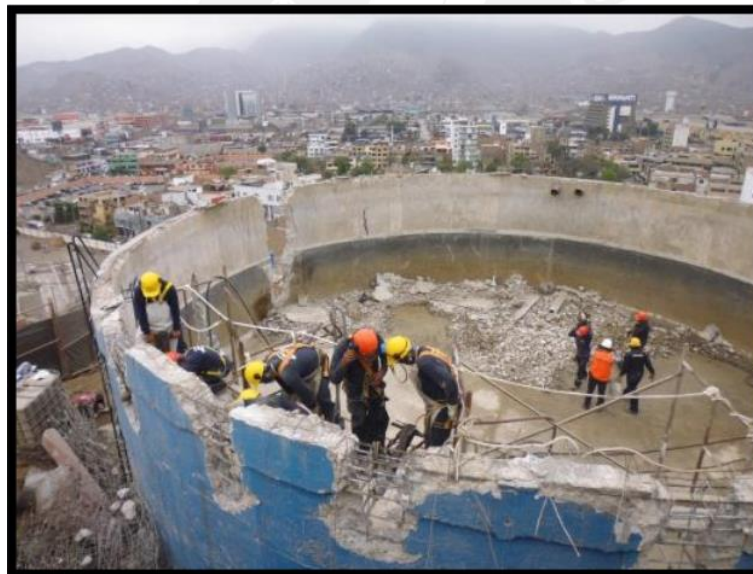
Figura N°3: Trabajos de demolición
