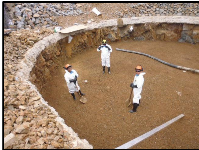
Figura N°5: Compactación de la zona, para posterior vaciado del solado del reservorio
