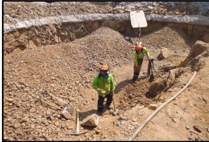
Figura N°4: Excavación en la zona del reservorio
