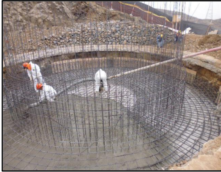
Figura N°7: Colocación del acero para zapatas y posterior vaciado de concreto
