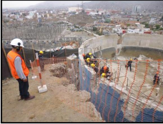
Figura N°1: Cercado de la zona de trabajo
