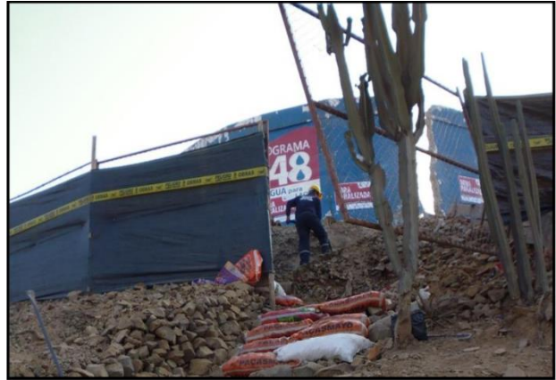
Figura N°2: Cercado de la zona de trabajo
