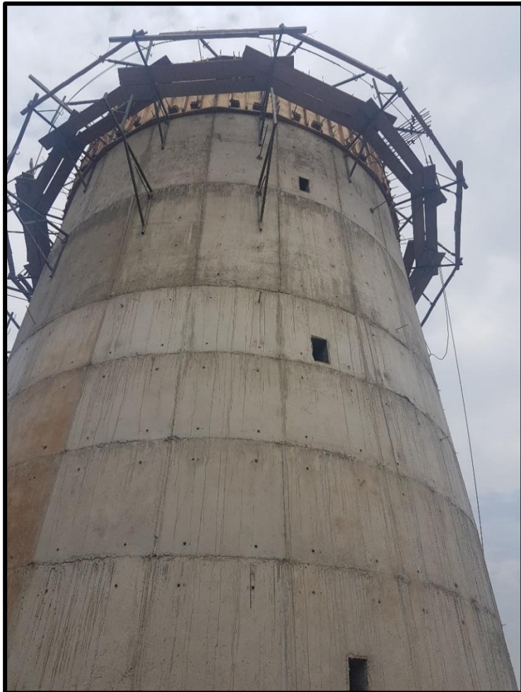
Figura N°8: Encofrado del último anillo del fuste
