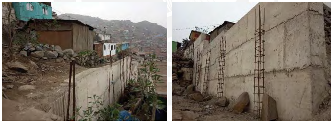
Figura 21. Muros de contención en asentamiento JCM. Archivo propio
