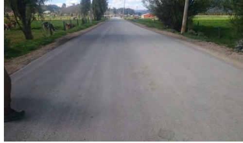
Ilustración 11. Estado final para la carpeta asfáltica
